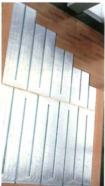
フローリング床暖房
