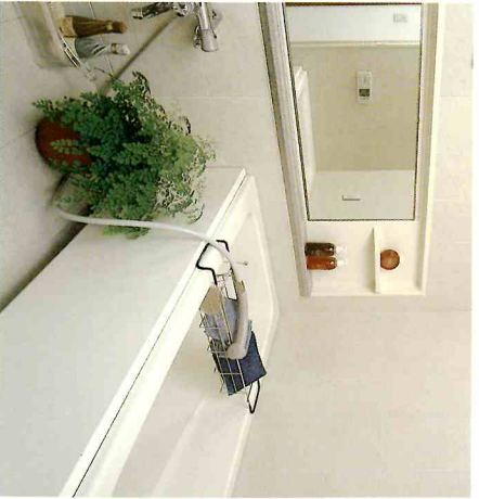
●浴室 浴室には手摺りが取り付けられるよう、あらかじめ下地を補強しました。(手摺りはオプション対応)
